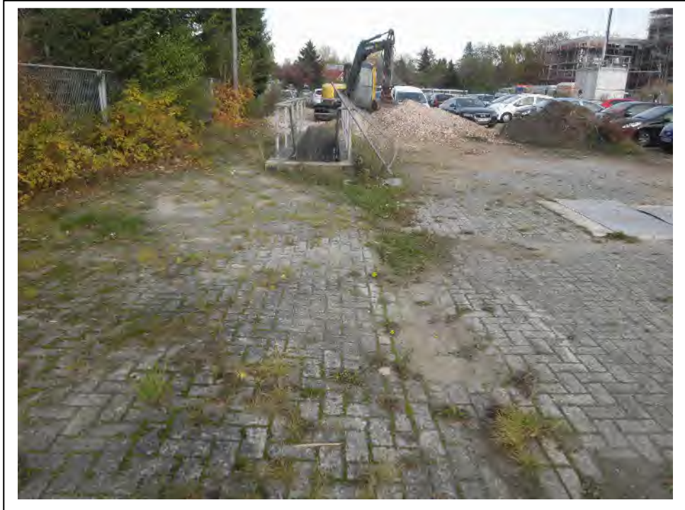
Foto 5: Blick zum Treppenabgang der Abwasserpumpstation (November 2018).
