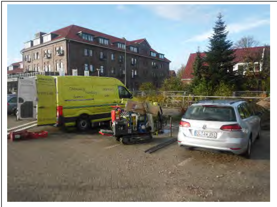
Foto 6: Beispiel: Ausführung der Bohrung KRB 44 im Bereich der Abwasserpumpstation (November 2018).
